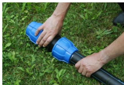
3. Løsne mutteren uten å ta den av, sett så røret inn i kontakten til riktig dybde er nådd.
